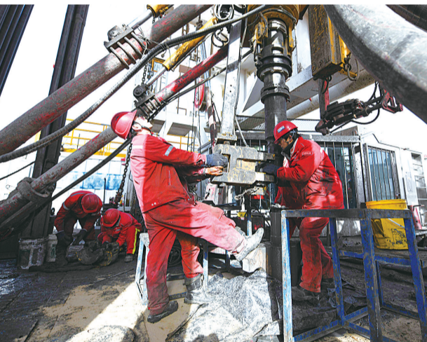
工人在中国石油塔里木油田深地塔科1井上作业(新华社图)
