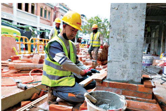
工人正在加班加点施工
