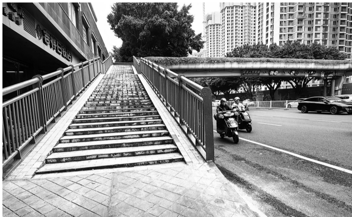
▶ 菏泽天桥已完成顺坡处理
