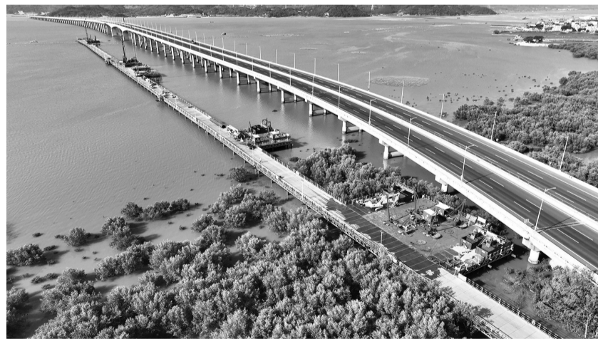
漳汕高铁漳江湾跨海特大桥桩基施工和栈桥施工(沈嘉鹏/摄)
