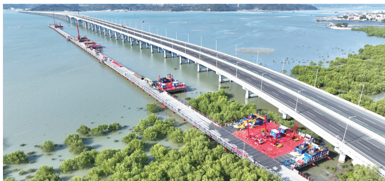
漳汕高铁漳江湾跨海特大桥桩基施工和栈桥施工 (沈嘉鹏/摄)
