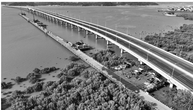
漳汕高铁漳江湾跨海特大桥桩基施工(沈嘉鹏摄)
