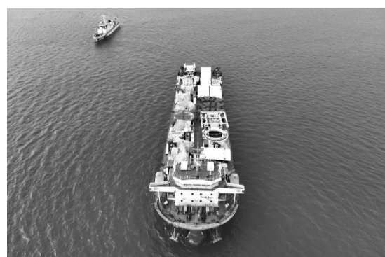
“厦金号”组件完成吊装作业
