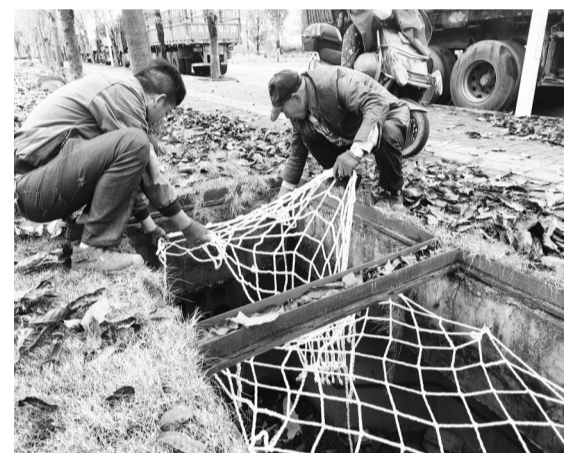
14日下午,有工作人员沿路给缺失盖子的窨井加装防护网
