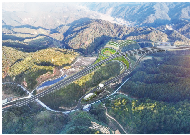
沙厦高速德化草村出入口工程项目正式开工
