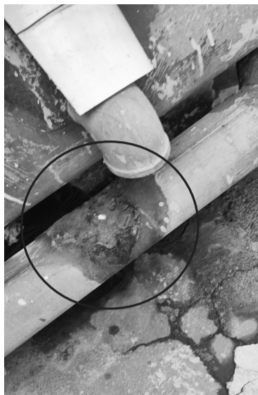
小区水管生锈,还在漏水
