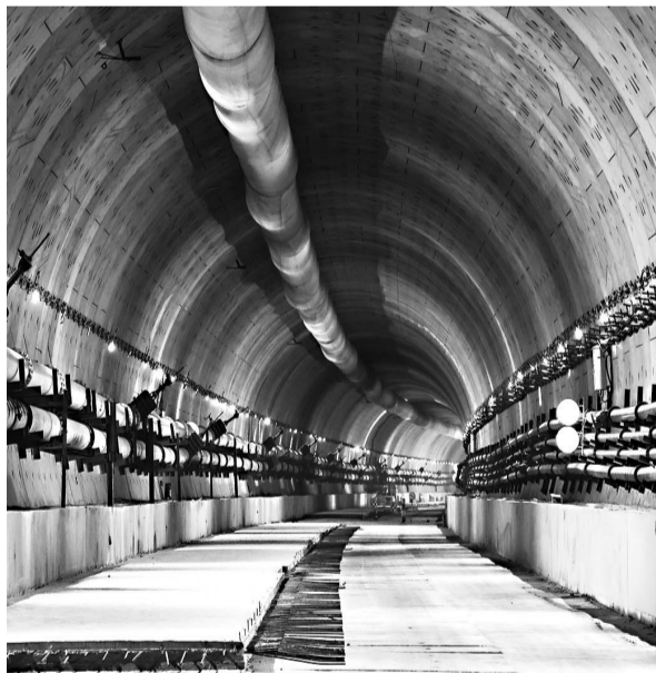
汕汕高铁汕头湾海底隧道盾构贯通段(3月26日摄)
