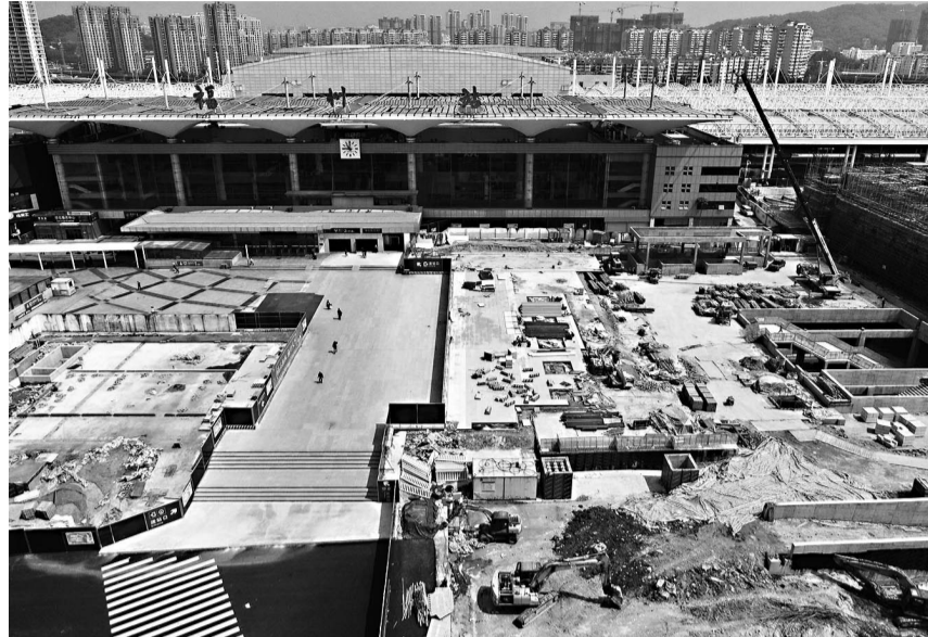
俯瞰火车站南广场工地
