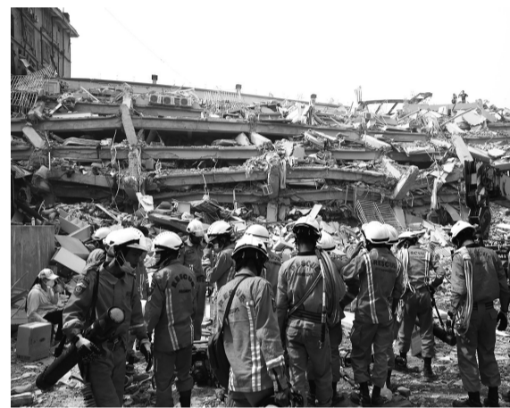
曼德勒市区一公寓建筑坍塌
