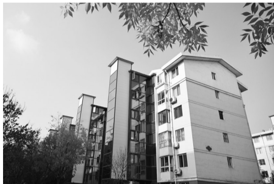
一小区在加装电梯 宁夏回族自治区银川市
