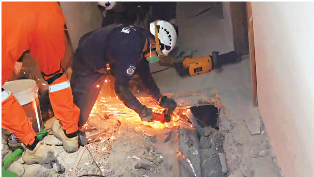
厦门曙光救援队以顶层向下破拆的方式,救援被困人员(图片均由厦门曙光救援队提供)
