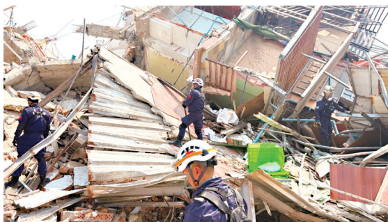
厦门曙光救援队在曼德勒一处废墟上搜救
