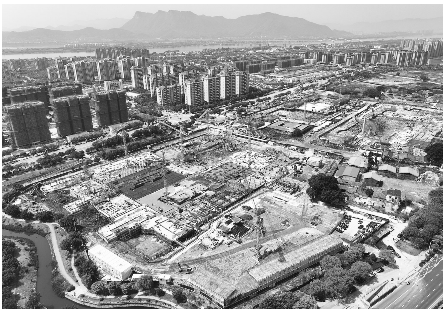
施工现场(受访方供图)
