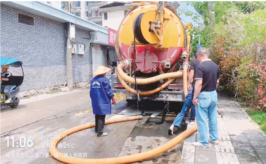
工人利用洗污车抽吸管道中的污水及杂物
