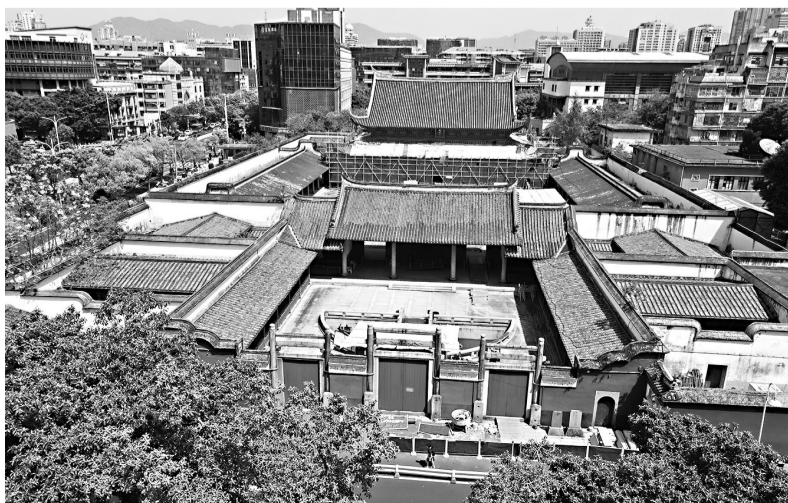
文庙前还立着多面施工围挡
