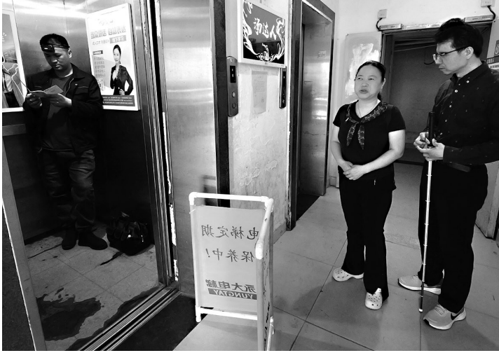
电梯内在加装施工,视障人士对语音播报系统充满期待
