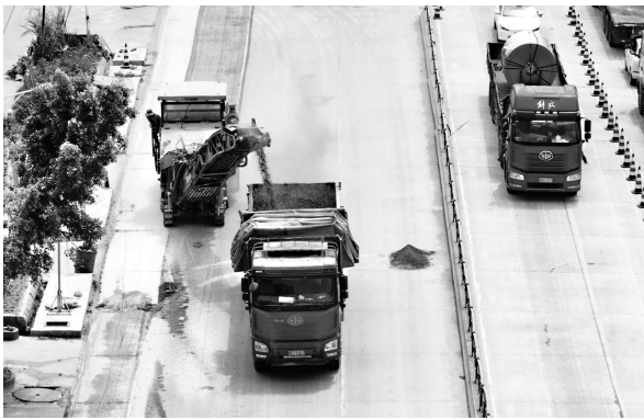
国道324线南安水头段施工现场(李想/摄)
