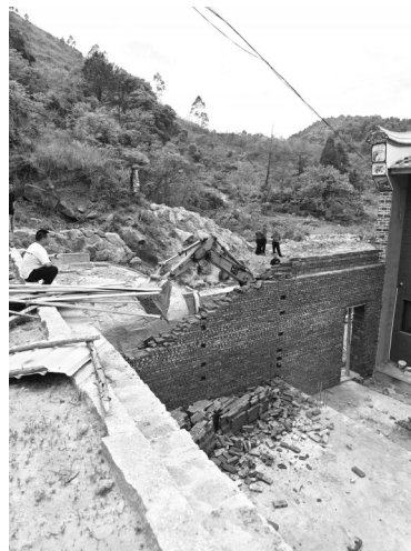
罗源县洪洋乡樟溪村拆违建围墙
