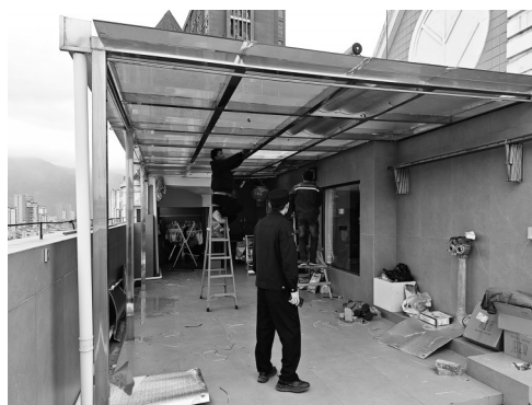
晋安区城综局五中队在当事人配合下拆除小区楼顶违建
