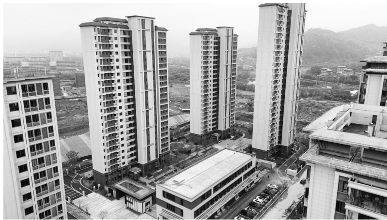
高新区南前五都安置房项目
