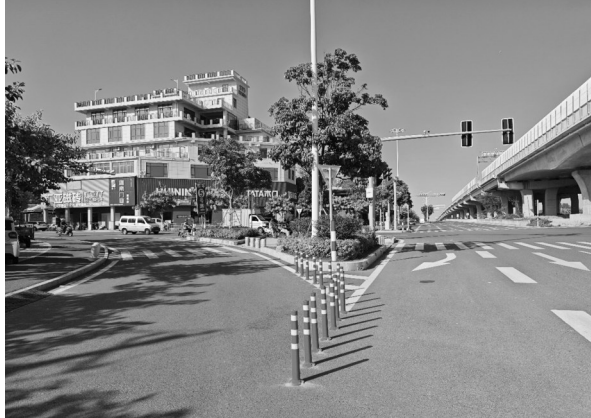
交警在匝道三角线区域增设塑料警示柱
