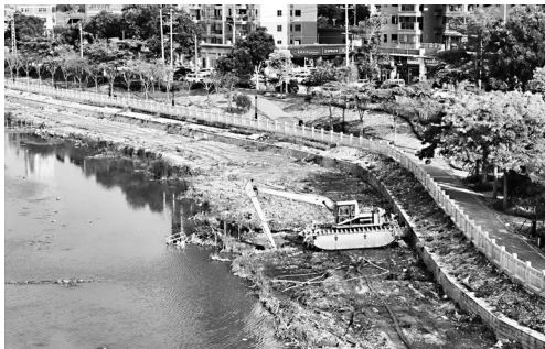
挖掘机正进行湖体清淤李想摄
