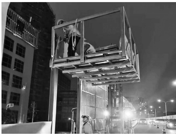
工作人员在更换声屏障 (部门供图)
