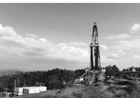
该井垂深超过5300米,刷新了我国页岩气井垂深纪录
