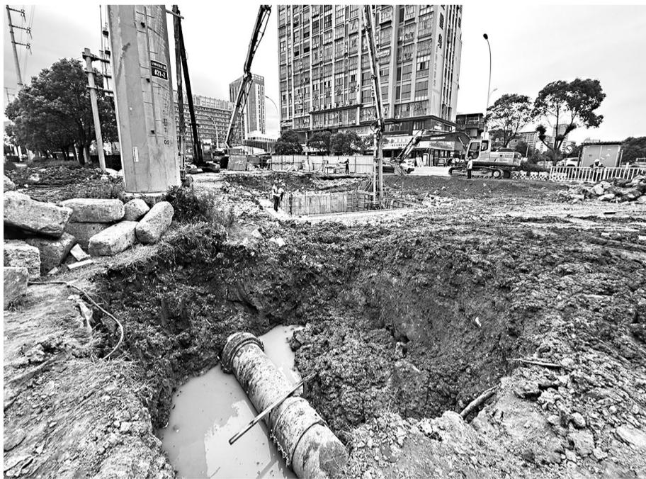
供热改造工程现场,土体下沉破坏管道
