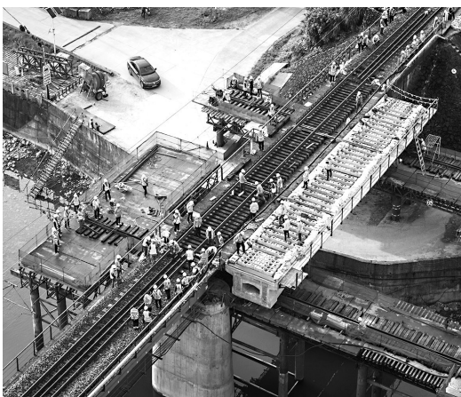
换梁施工现场(徐亮/摄)
