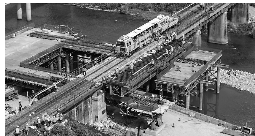
梁体更换后大型养路机械正在作业(徐亮/摄)
