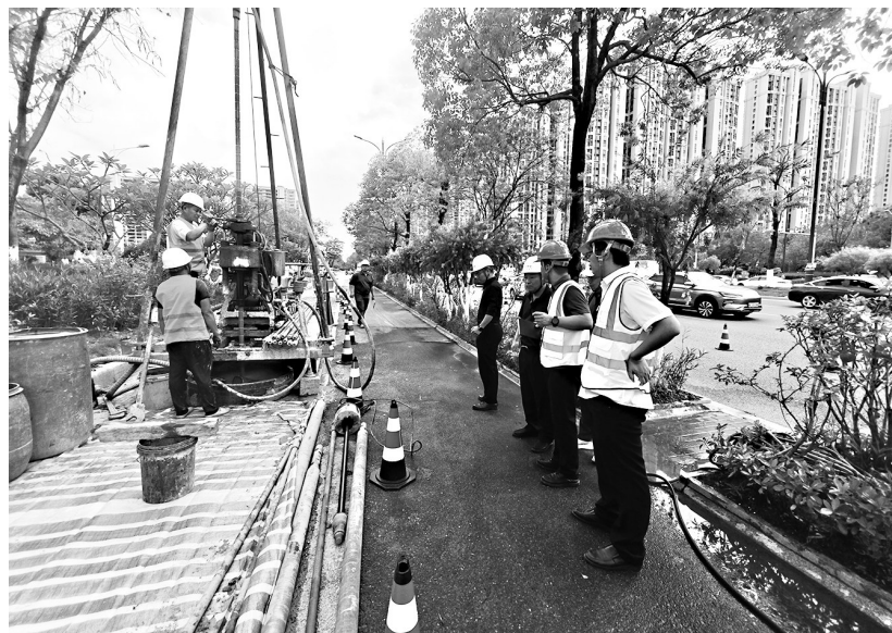
钻探设备进场施工,启动实地勘察
