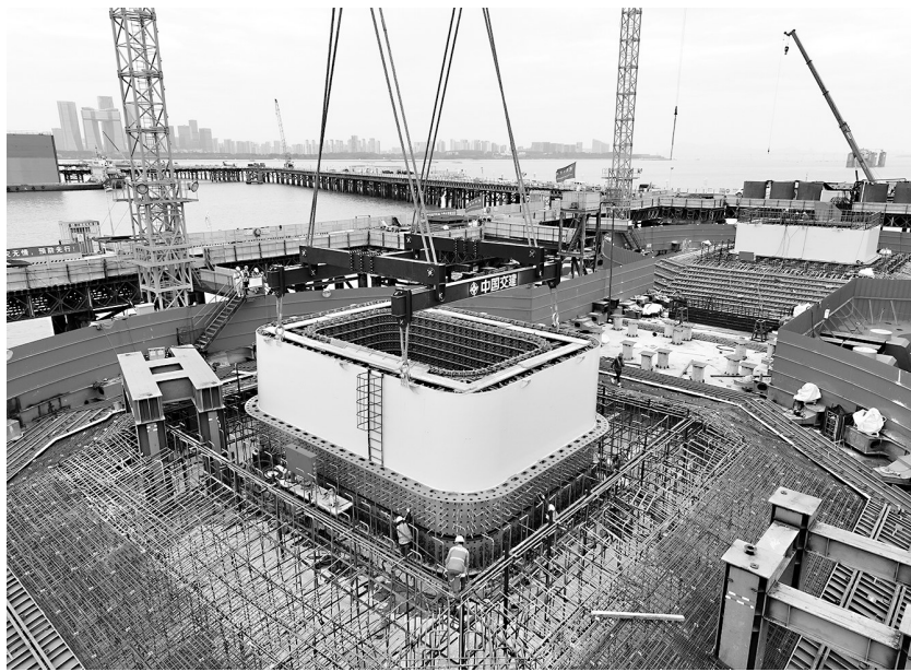
西主塔首节段落位施工现场(福建日报图)
