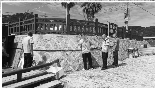
◀执法人员拆除违规安装的水龙头
