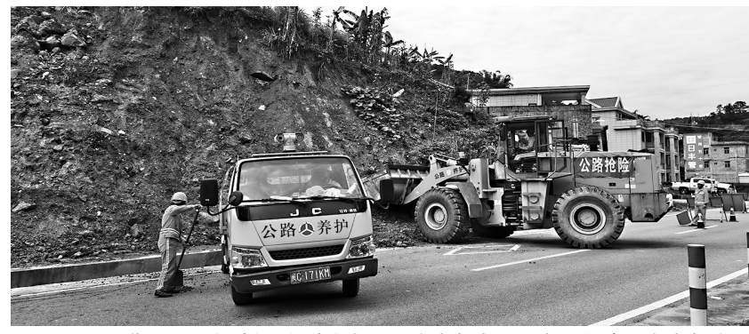
国道 355 线安溪段,安溪分中心公路应急中队正在进行清溜方应急演练
