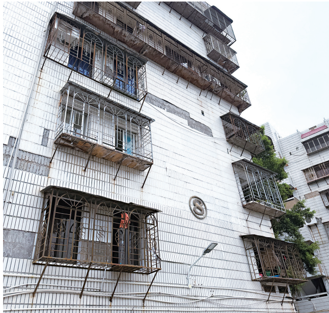
► 广益新村小区外墙改造前
