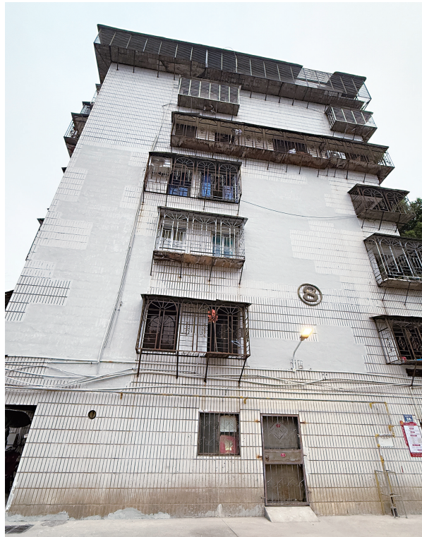
广益新村小区外墙改造后
