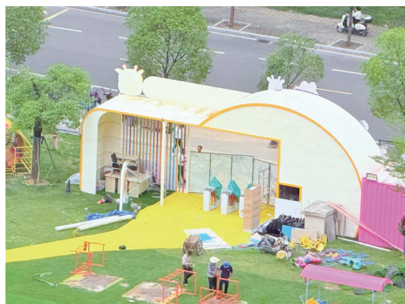
工人进场拆除
