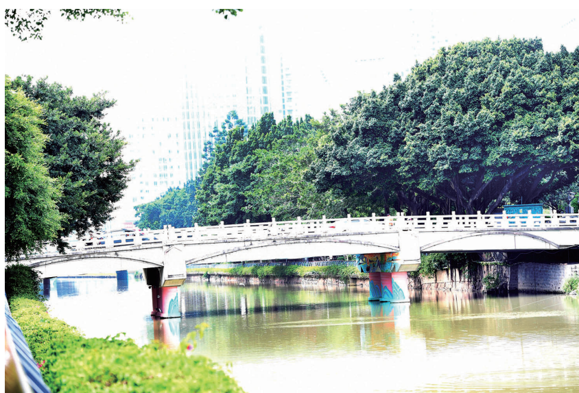
尾路桥桥墩,已化上了「彩妆」
