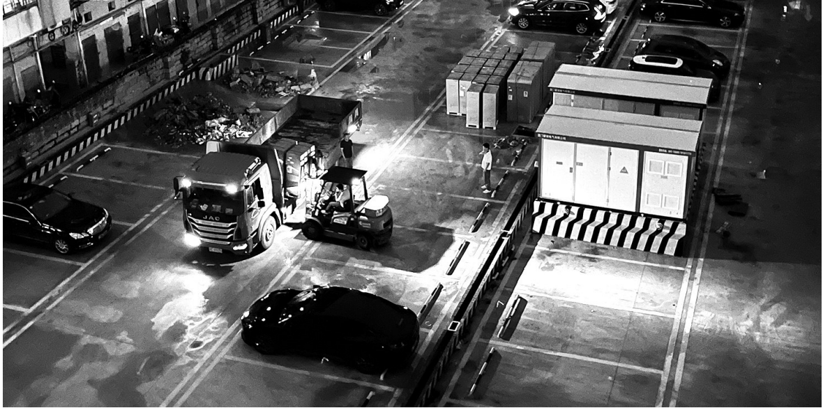
5月29日晚上10点多,居民拍到一辆大卡车将一批充电桩设备运进了小区停车场
