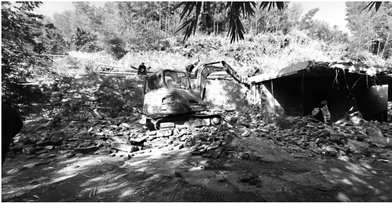
樟城镇一处占地违建被依法拆除
