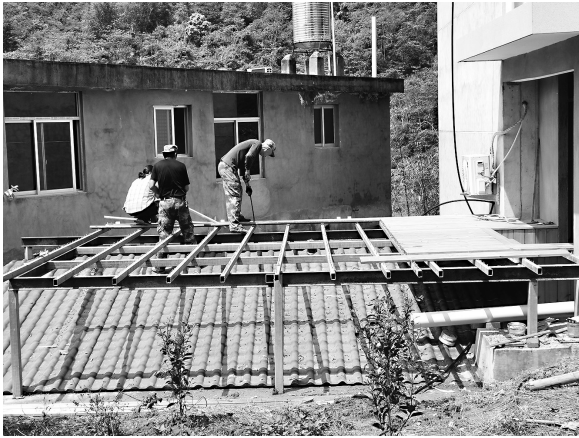
梧桐镇开展违建拆除行动
