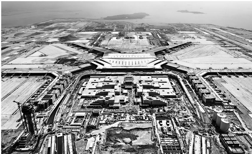
在建的厦门翔安国际机场
