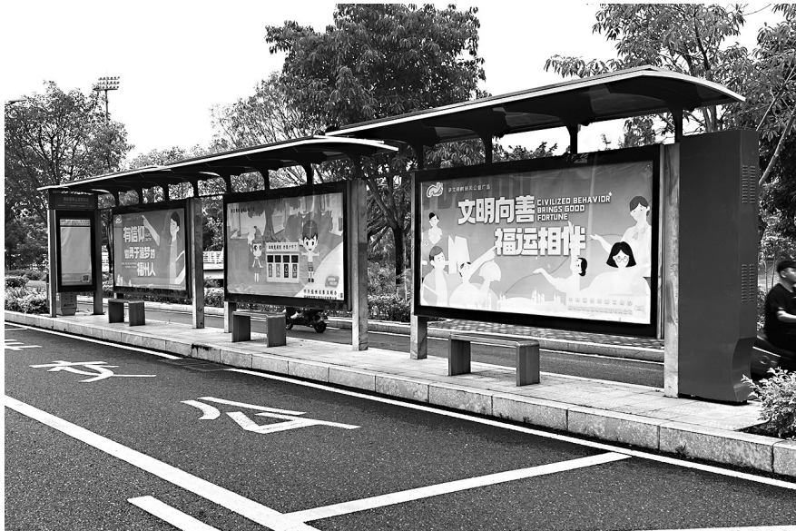
海峡奥体公交枢纽站(东侧)成为福州首座光伏公交站台
