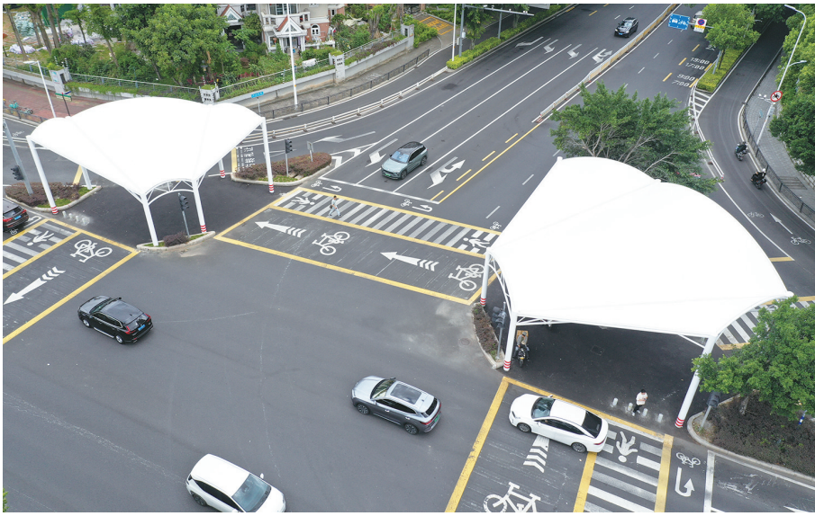
江滨西大道-乌山路口的遮阳棚已完工
