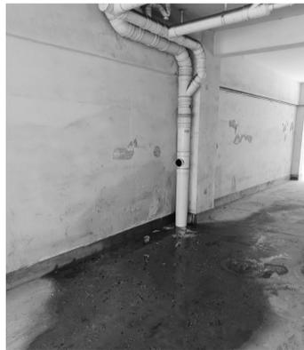
打开架空层主管道,大量污水涌出
