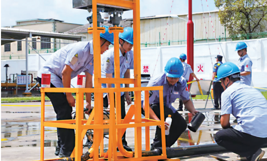
燃气泄漏事故 多部门联动演练应急处置
