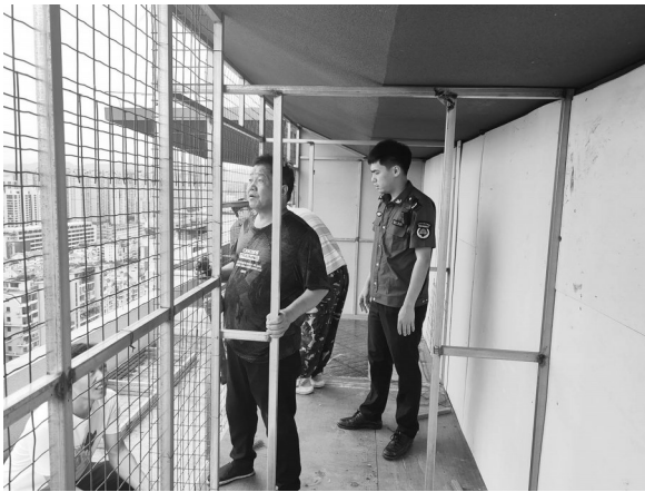
依法拆除夏荷郡小区楼顶影响消防安全违建
