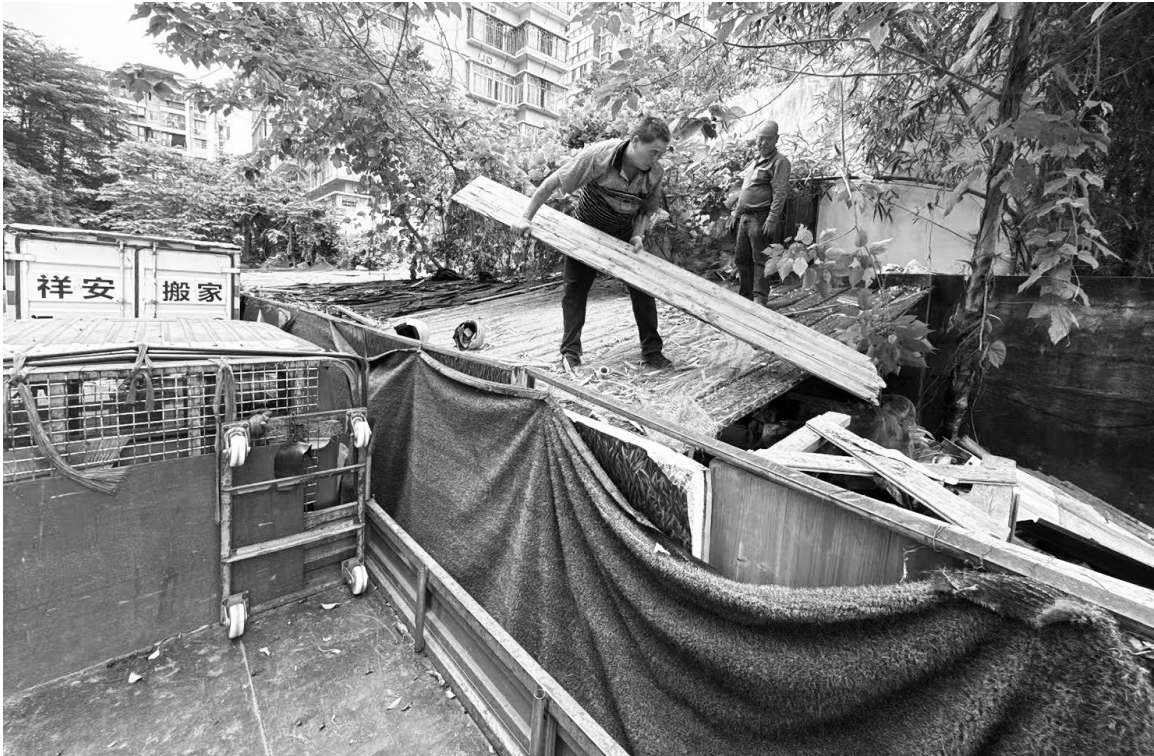
后厨违建被顺利拆除
