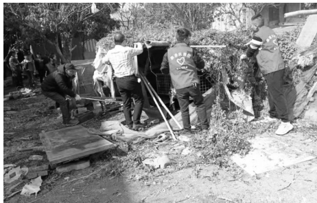
拆除鸡窝鸭舍
