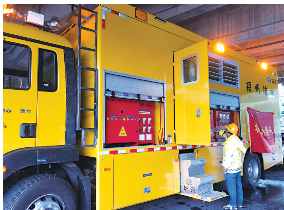
工作人员检查抢险作业车
