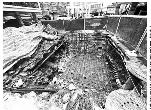
基坑内钢筋结构框架已建好
