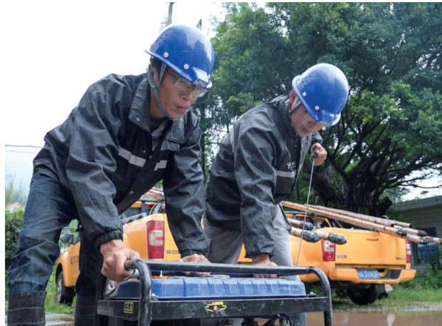
▲ 使用发电油机为基站供电
