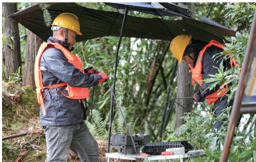
◀ 抢修人员熔接受损光缆
