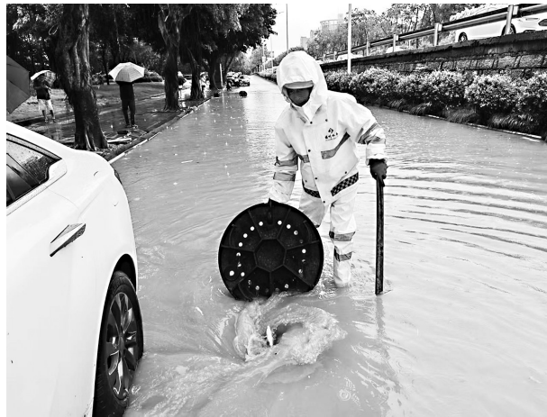
首山人行天桥开井盖强排(福州市排水公司供图)
