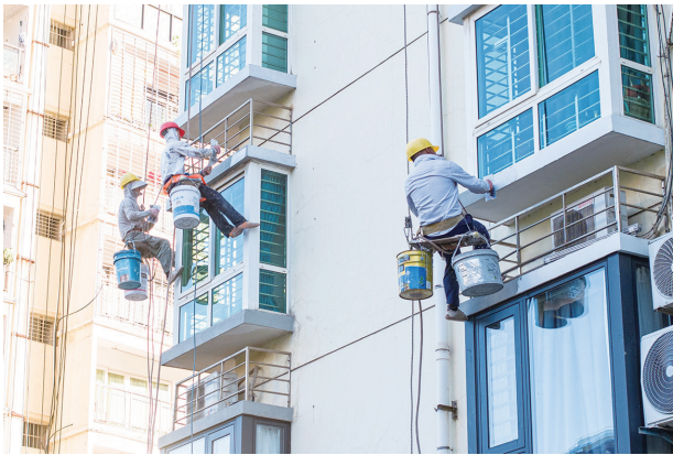
整治外墙脱落
