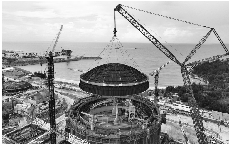
中广核广东陆丰核电6号机组穹顶吊装现场(受访单位供图)
