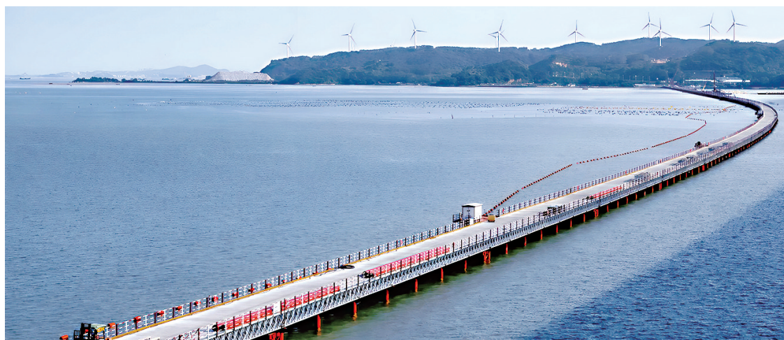
漳江湾跨海特大桥主栈桥完工
