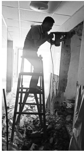
工人正在凿墙(受访者供图)
